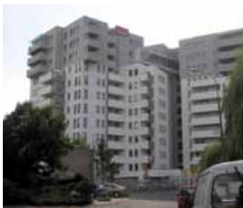
Apartamentowiec „Pelikan”, Poznań
