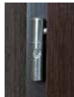
zawias czopowy wkręcany typ D
