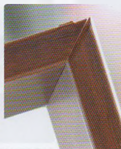
POŁĄCZENIE BELEK OŚCIEŻNICY STALOWEJ POD KĄTEM 45°
