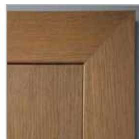
łączenie opasek pod kątem 45°
