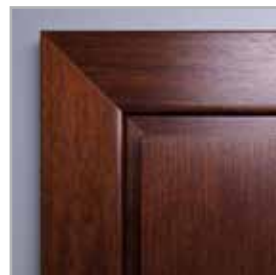
łączenie opasek pod kątem 45°
